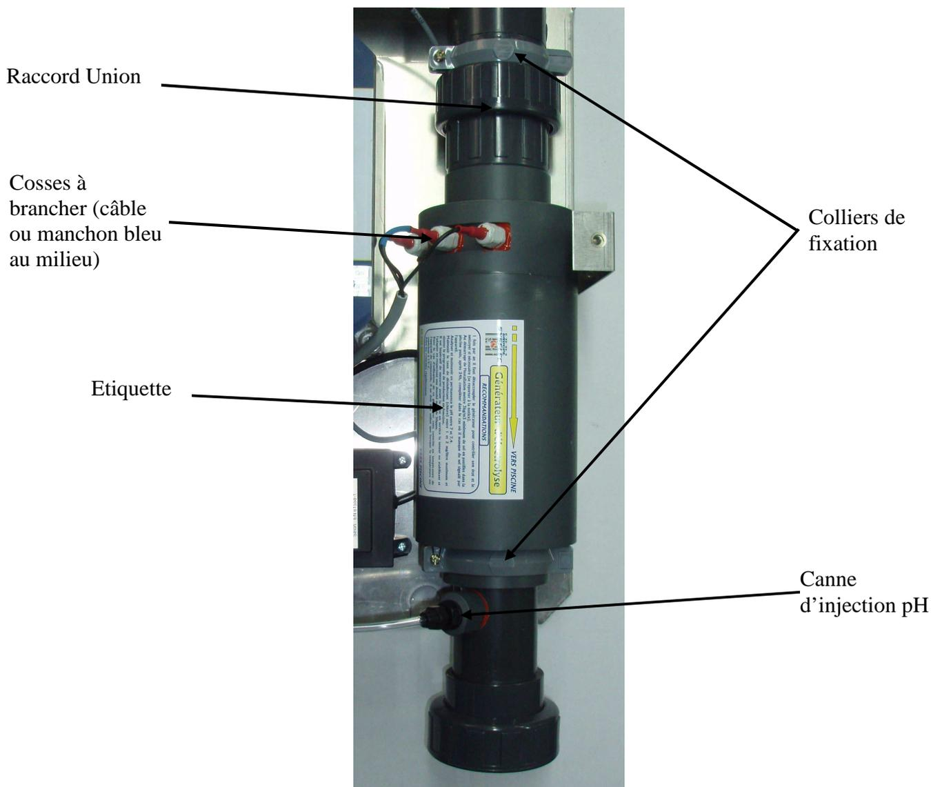
Brancher les cosses sur la cellule, le câble bleu (ou avec le manchon bleu) doit être monté sur la cosse du milieu, et la canne d'injection de pH sur le bas de la sonde (Attention vérifier l'étanchéité, injection d'acide).
