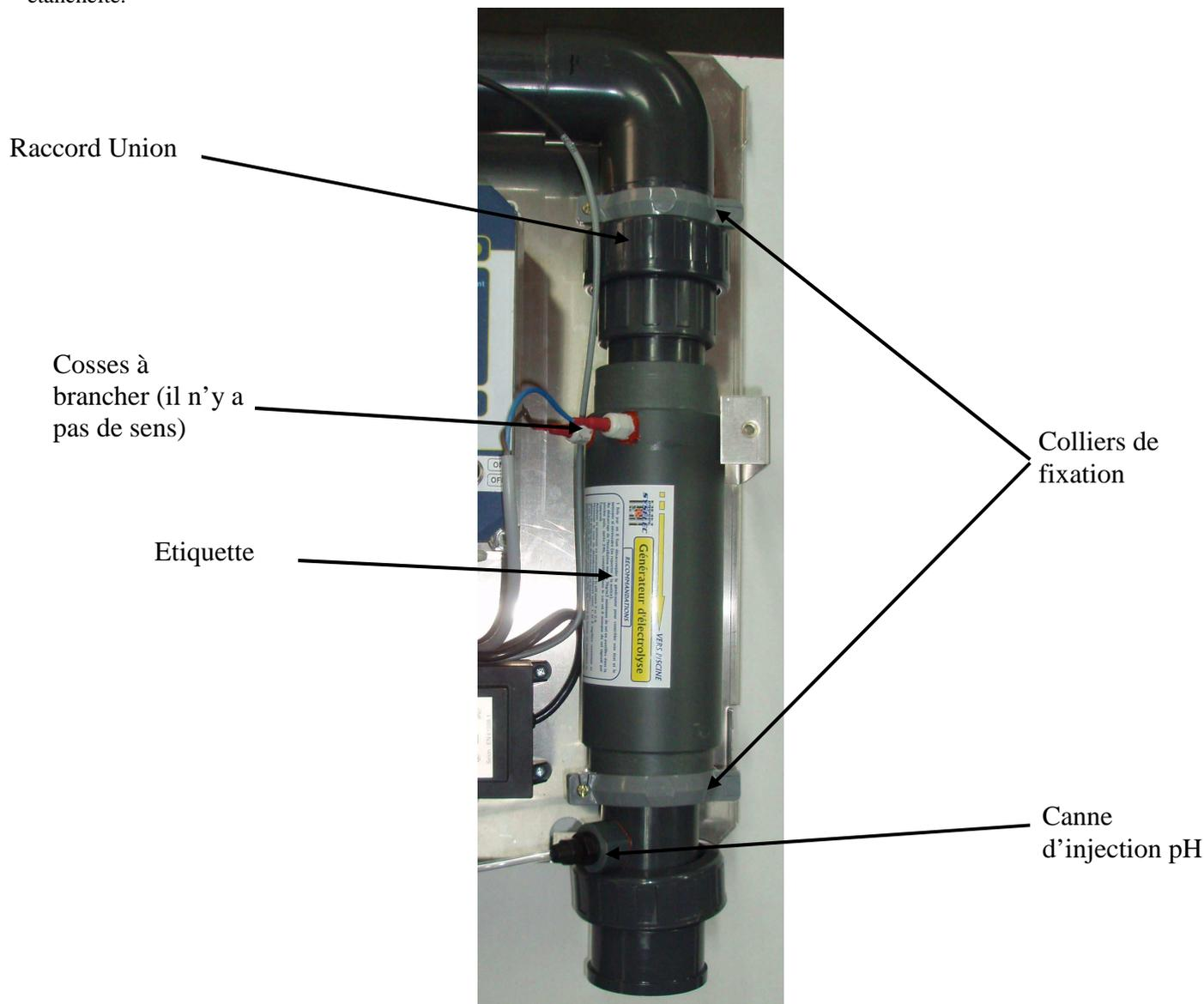
Brancher les cosses sur la cellule (il n'y a pas de sens) et la canne d'injection de pH sur le bas de la cellule (Attention vérifier l'étanchéité, injection d'acide).
